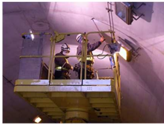
写真 2-1 トンネル点検状況
