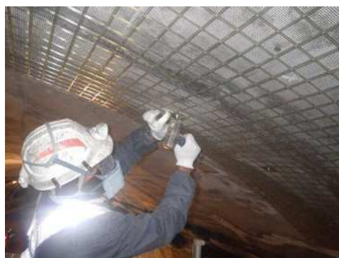
写真 3-1 FRP ネット設置状況
