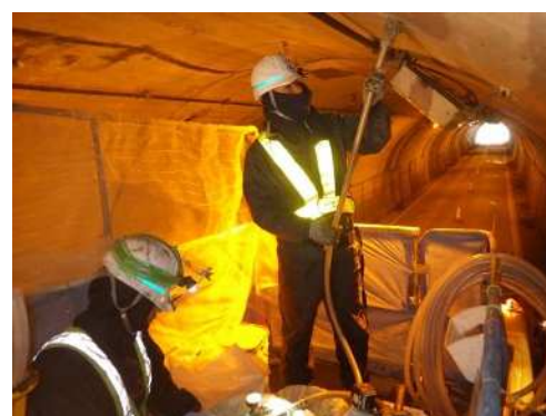
裏込注入状況
