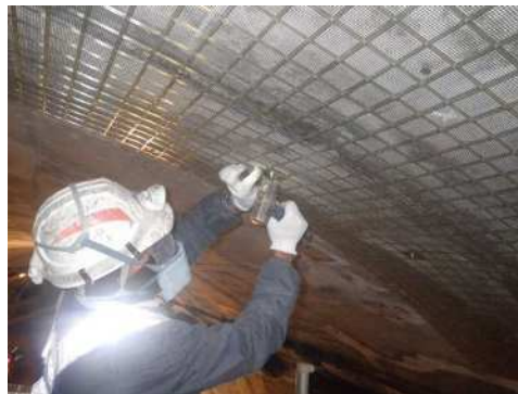
写真 3-1 FRP ネット設置状況
