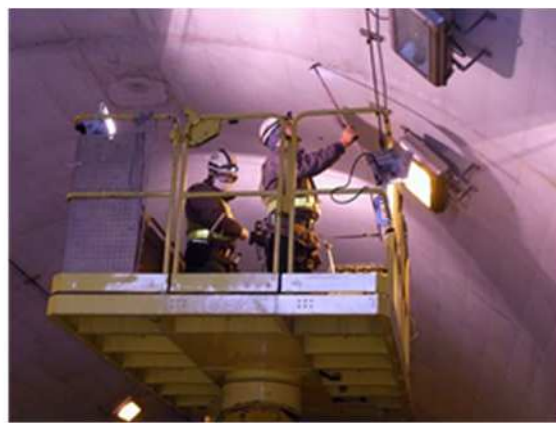
写真 2-1 トンネル点検状況
