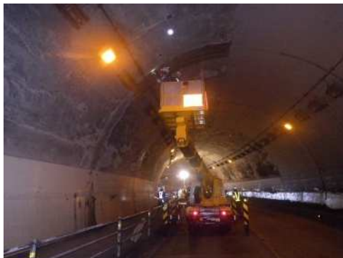
写真 3-1 FRP ネット設置状況
