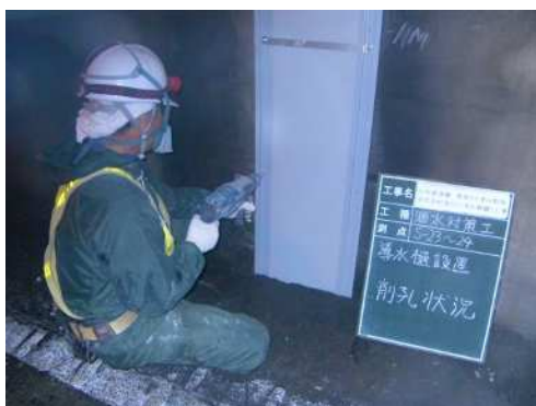
写真 3-2 線導水工
