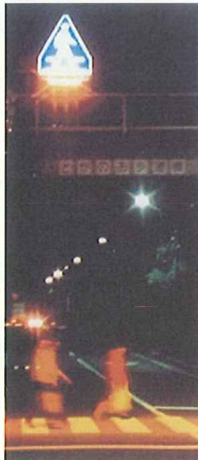
歩行者感知内照型 標識の設置
