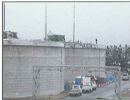
汚泥処理施設の増設・改築
