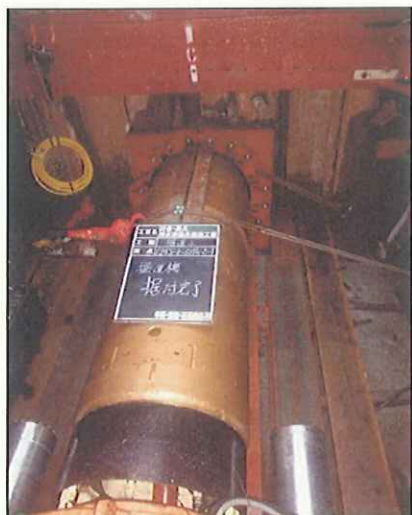
汚水幹線の整備
