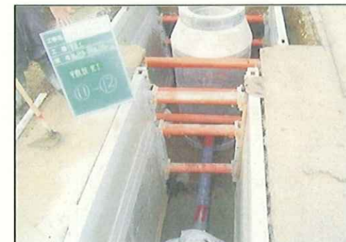
汚水枝線の整備
