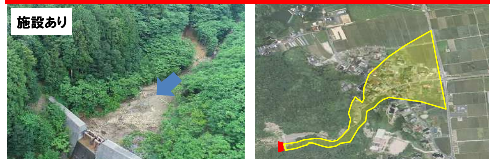
砂防堰堤による土砂捕捉
