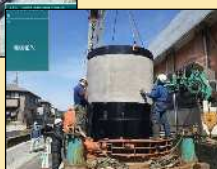
排水ポンプ設置状況
