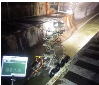
自走式テレビカメラによる調査状況
