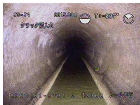
自走式テレビカメラによる撮影状況
