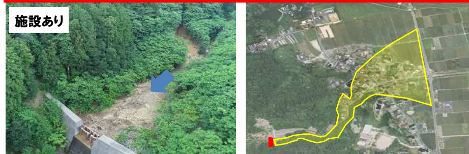
砂防堰堤による土砂捕捉
