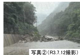
たたき落としにより発生したコンクリート片
