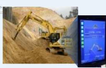
3Dデータを利用した機械施工
