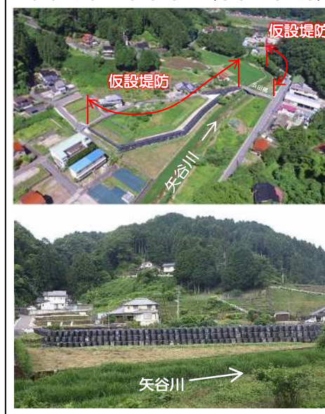
仮設堤防の設置状況(令和4年8月)
