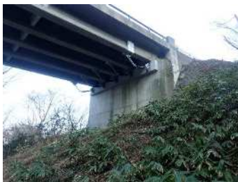
落橋防止構造
