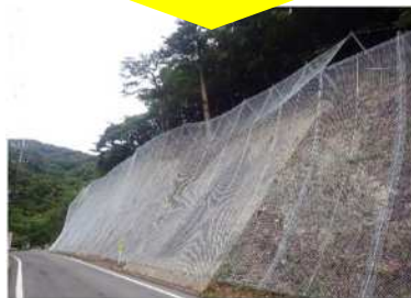
道路への落石防護ネット設置 [西郷都万郡線：隠岐の島町]
