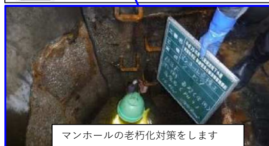
【マンホール躯体（東部浄化センター）】
