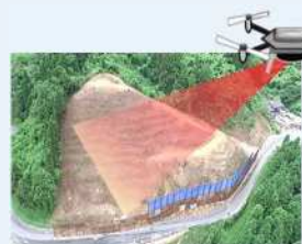
ドローンによる3D測量
