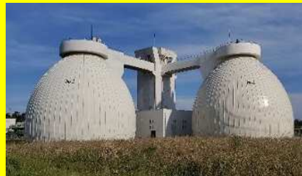
汚泥消化タンク 【西部浄化センター】
