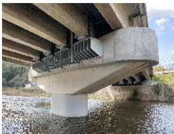
水平力分担構造
