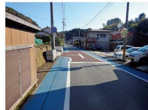
（一）池田中町線（隠岐の島町）
