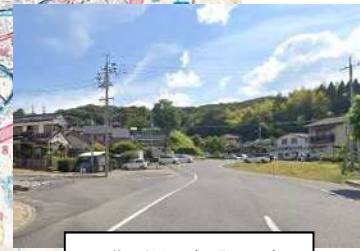
現道の状況 (2期区間)
