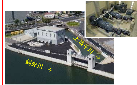
上追子川排水機場 (R3.9完成)
