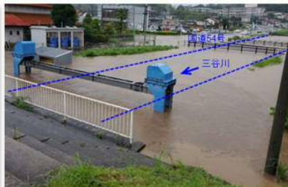
写真② 三谷川周辺浸水状況 (R3.7.12)
