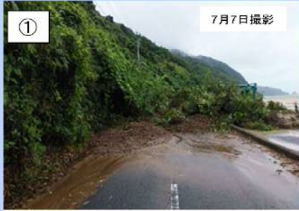
(主)斐川一畑大社線 出雲市河下町～猪目町 (法面崩落)
