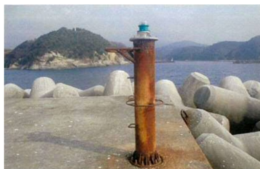
写真－１６ 小規模な施設修繕
