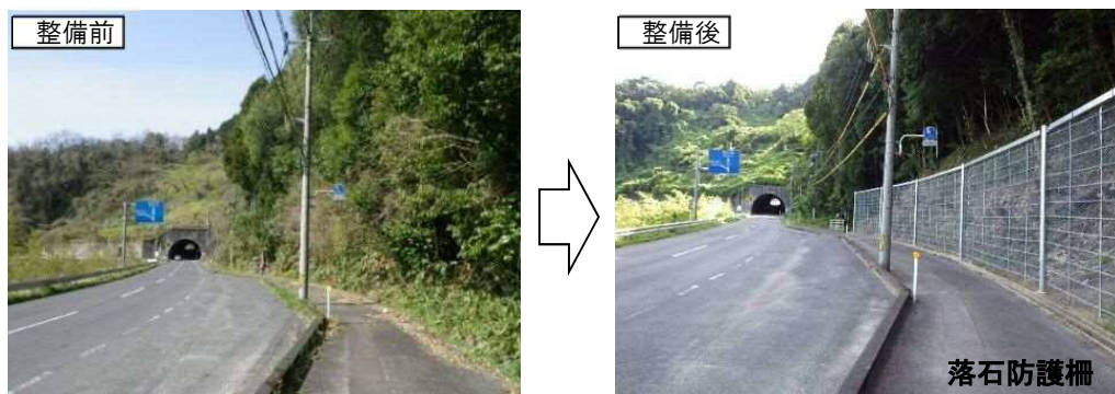
国道 432 号(安来市広瀬町)
