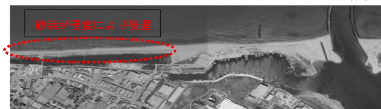
写真－8 例) 港湾海岸の侵食(益田港海岸)
