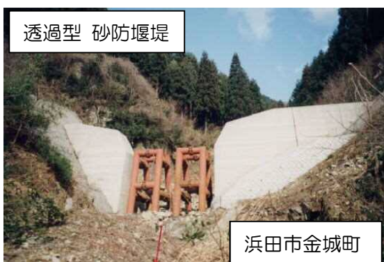
土砂・流木捕捉状況
