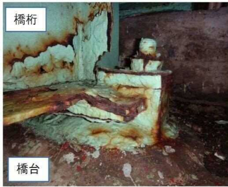
〔橋台〕 平成 26 年点検
