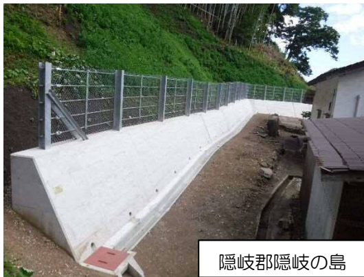
写真－３ 擁壁工
