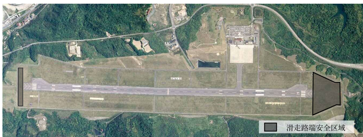
写真一6 現在の滑走路端安全区域（萩・石見空港）
