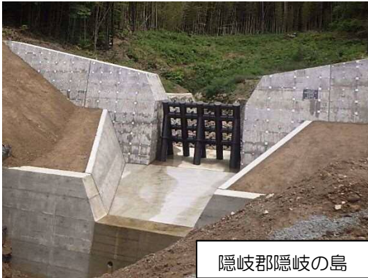
写真－１ 砂防堰堤
