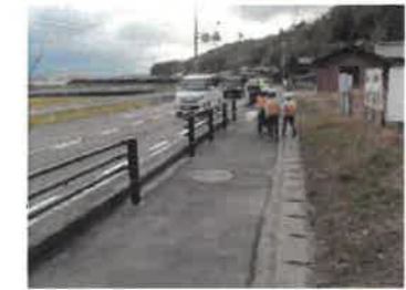
国道431号(出雲市)
