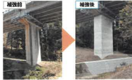
国道191号 堀越橋(益田市)
