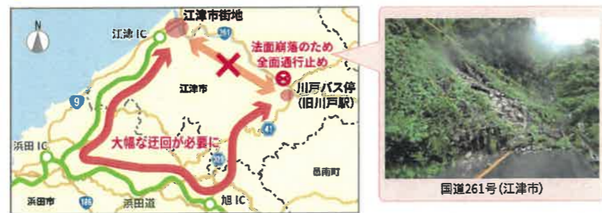
豪雨等による道路災害の事例(国道261号)
