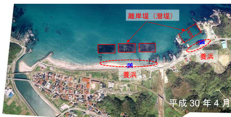
写真－10 (三隅港海岸) 侵食対策
