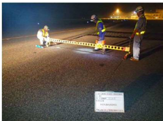
写真一4 滑走路定期点検状況
