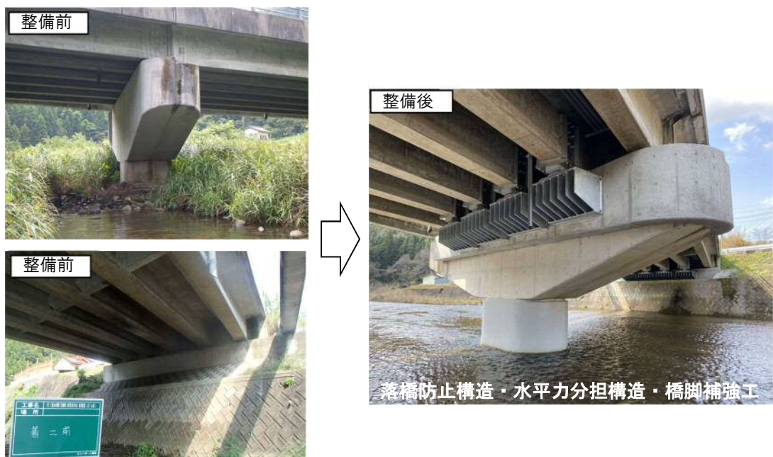
模原橋 (主) 三瓶山公園線 (大田市大田町)
