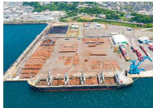
写真－2 貨物船 (原木) の岸壁利用とふ頭用地
