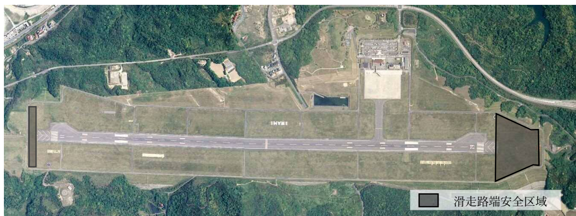
写真一6 現在の滑走路端安全区域（萩・石見空港）
