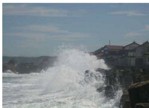
(高潮による越波状況)
