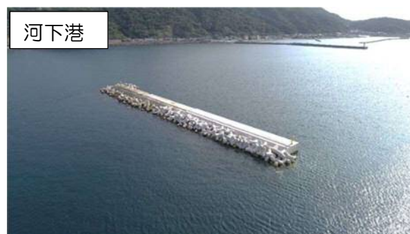
写真-6 沖防波堤の整備
