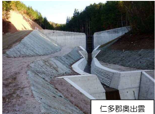
写真－２ 砂防堰堤と流路工
