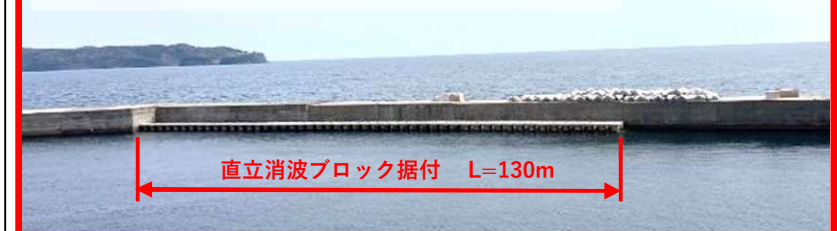
防波堤改良 L=130m (R7.3に完成)
