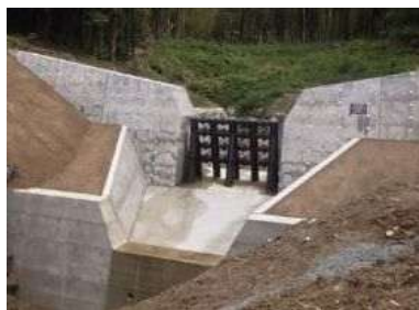
砂防堰堤工
