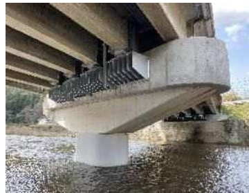
水平力分担構造
