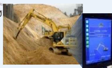
3Dデータを利用した機械施工
