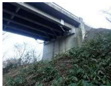
落橋防止構造
