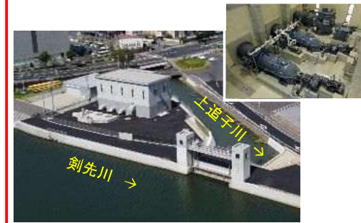
上追子川排水機場（R3.9完成）
