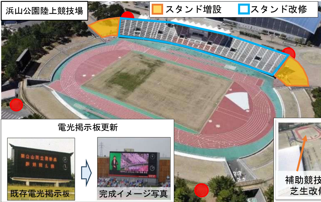
● 照明施設新設
