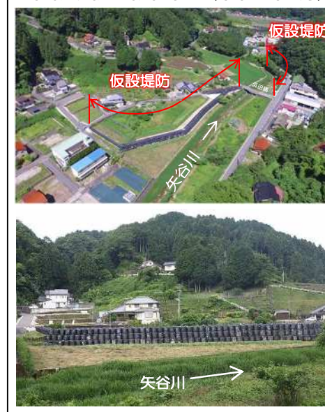
仮設堤防の設置状況(令和4年8月)
