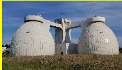
汚泥消化タンク 【西部浄化センター】
