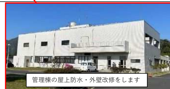
【管理棟（西部浄化センター）】
