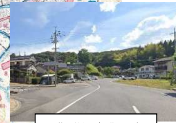
現道の状況 (2期区間)
