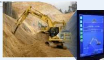
3Dデータを利用した機械施工
