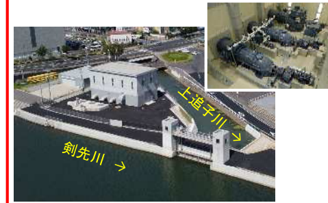
上追子川排水機場 (R3.9完成)
