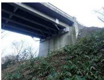
落橋防止構造
