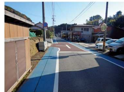
（一）池田中町線（隠岐の島町）
