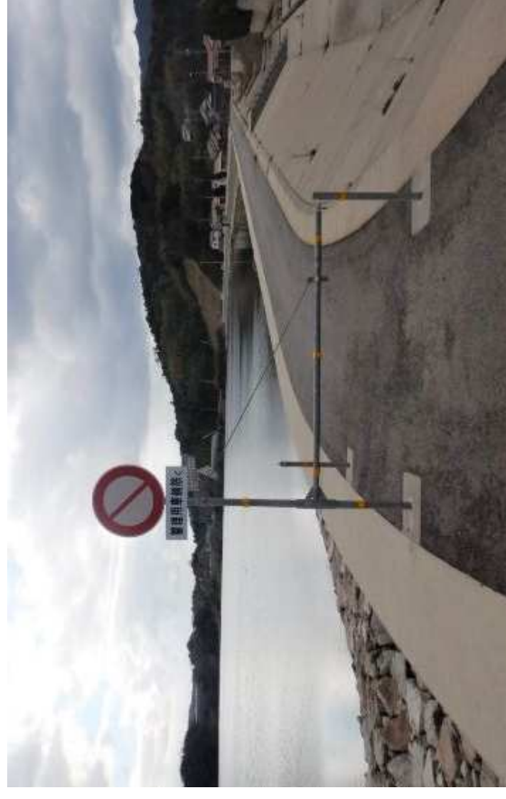
舗装済の河川管理用通路とサイクリングに支障となる車止め
