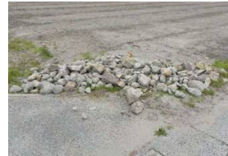
他工事流用土：石の混入
