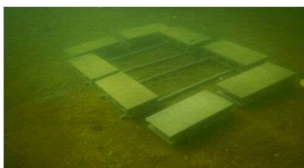
ブロックと塩ビパイプによる簡易構造物 (H30)
