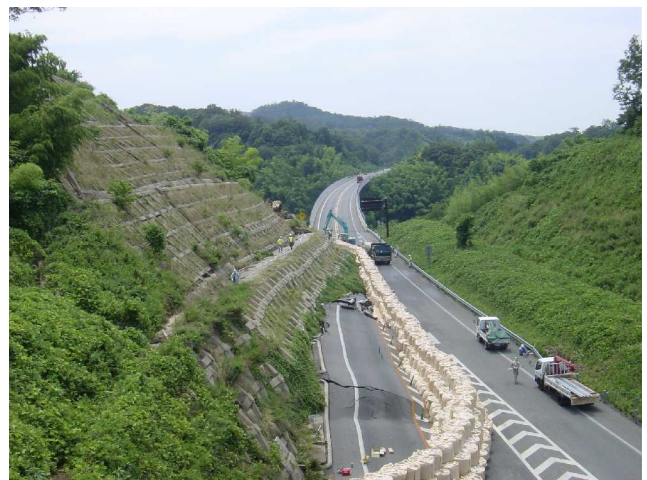
山陰自動車道被災現場（H18.7.18）
