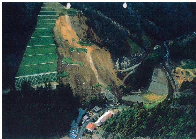
法面崩壊状況
