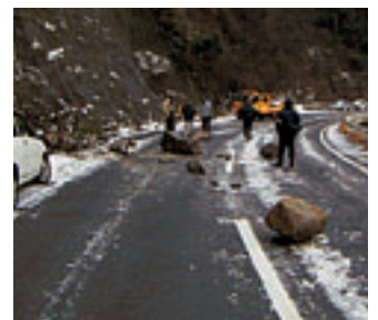
④落石が生じた山間道路 (主)浜田作木線
