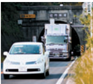
①内空断面が狭く背高コンテナが通れないトンネル(6箇所) (国道9号)
