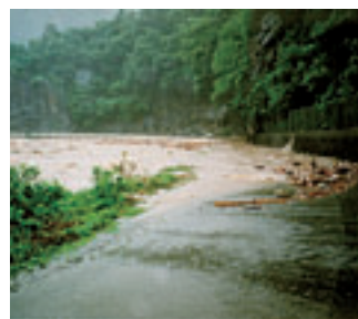
②増水時には通行不能になる幹線 (国道488号)
