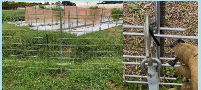
図2 設置したワイヤーメッシュ柵と破損した結束バンド
