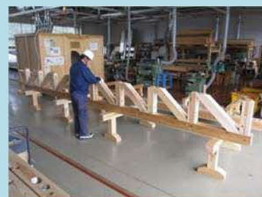
トラス梁の組立て
