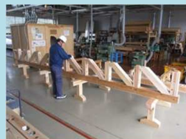
トラス梁の組立て
