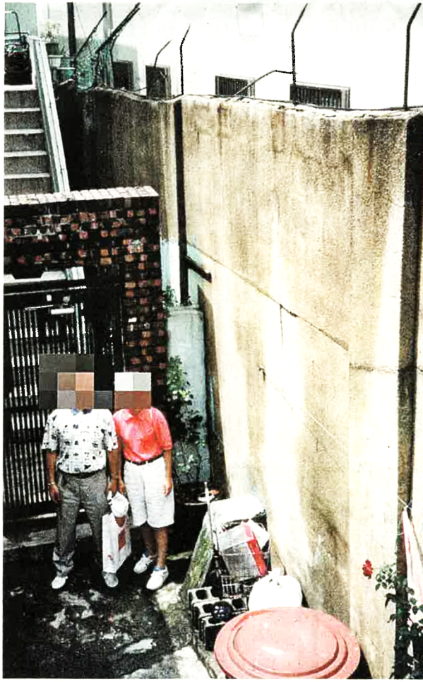
釜山にあった外国人収容所の跡地に残る外壁（1999年、藤井賢二氏撮影） ※一部画像を加工しています
