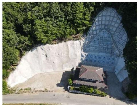
山腹工（法枠工、アンカー工）
