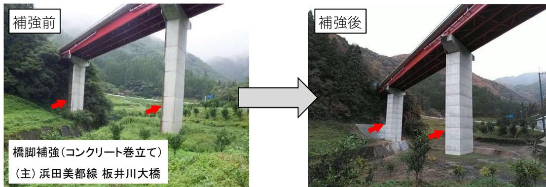
地震時に橋脚が壊れないようにコンクリート等で補強する橋脚補強や、橋が落ちないようにするための落橋防止対策をおこなっています。
